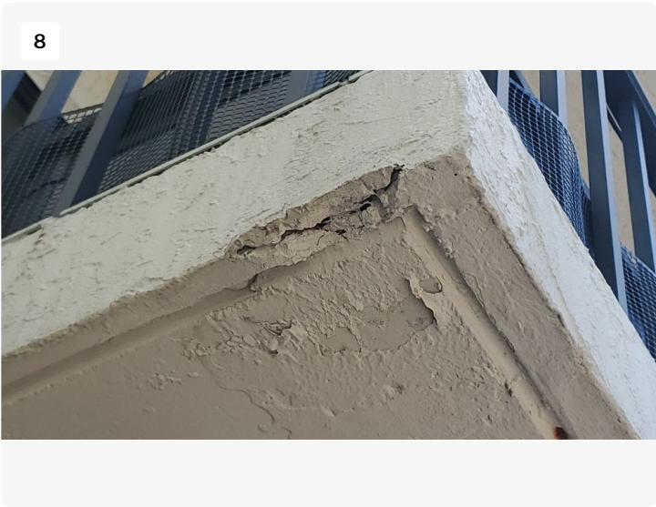
Slab edge spall.
